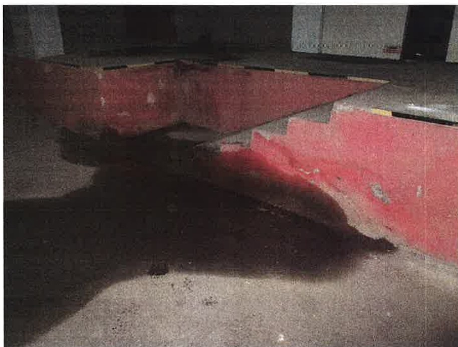
Zatékání dešťové vody do 1.PP
